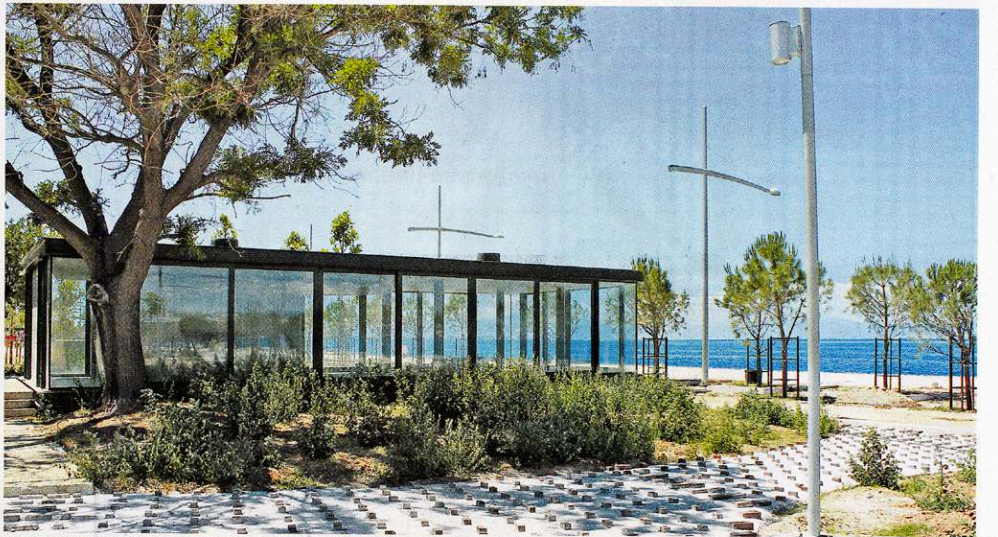
Ένα από τα νέα αναψυκτήρια που κωροθετούνται στο πλαίσιο της δεύτερης φάσης ανάπλασης: τους θερινούς μήνες οι υγρές επιφάνειες απομακρύνονται και ο χώρος αποκτά φυσικό αερισμό. Στο βάθος διακρίνεται η αλέα με τα πεύκα, που σηματοδοτεί τη σκιασμένη διαδρομή.
